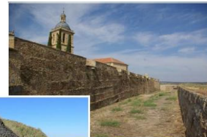
▲ Vista del área norte de la muralla desde el camino cubierto.
