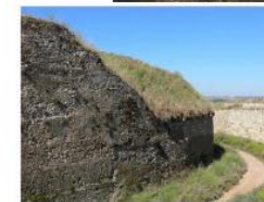
▲ Detalle de la esquina noroeste, desde el foso.
