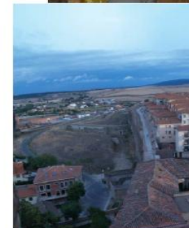
▲ Vista cenital de la ronda de la muralla sobre la puerta de la Colada.
